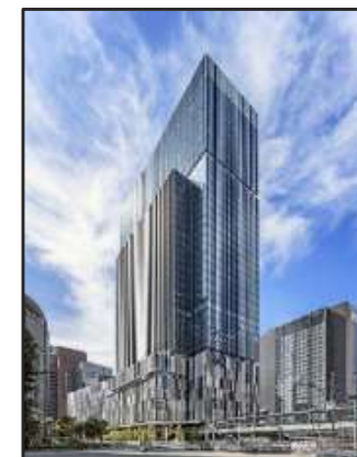
JPタワー大阪 (KITTE大阪) 所在地：大阪市 延床面積：227,000㎡ 竣工：2024/3
