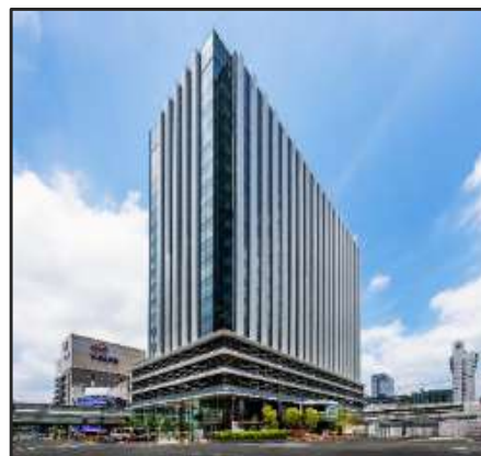
広島JPビルディング 所在地：広島市 延床面積：44,200㎡ 竣工：2022/8
