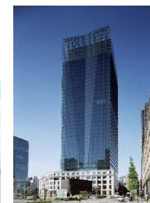
J Pタワー （2012年5月竣工）
