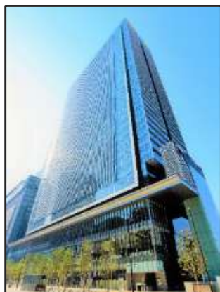
JPタワー名古屋 (KITTE名古屋) 所在地：名古屋市 延床面積：180,000㎡ 竣工：2015/11
