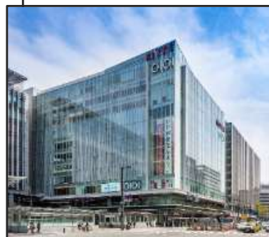
KITTE博多 所在地：福岡市 延床面積：64,300㎡ 竣工：2016/3
