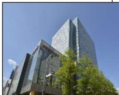
札幌三井JPビルディング 所在地：札幌市 延床面積：68,190㎡ 竣工：2014/8
