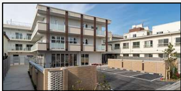
グランダム白式番館・ベネッセ目白保育園（高齢者・保育施設）
