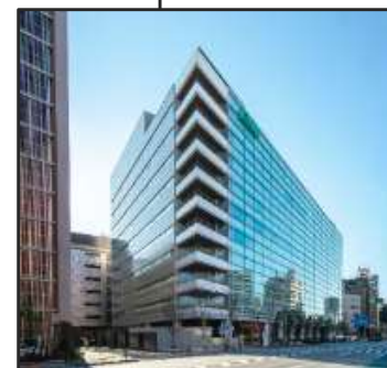
蔵前JPテラス 所在地：東京都台東区 延床面積：99,700㎡ 竣工：2023/3
