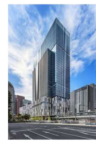
JPタワー大阪 （2024年3月竣工）
